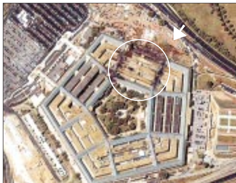
Panorámica muestra la parte destruida del Pentágono.
