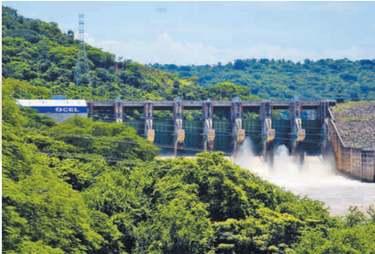
LA GENERACIÓN DE ENERGÍA podría crecer el próximo año y, con ello, la distribución a los hogares que por hoy no tienen electricidad. FOTO EDH / ARCHIVO
